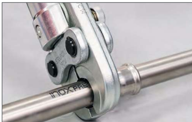
Assemblaggio attraverso pressatura / Making the press connection
