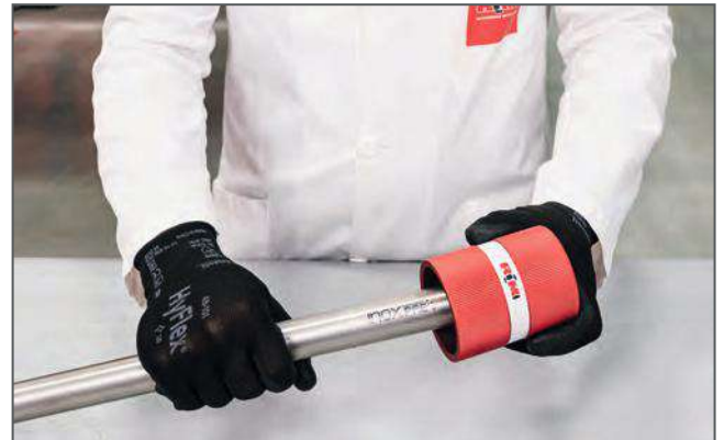
Sbavatura del tubo / Deburring the pipe
