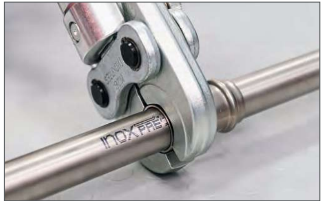
Assemblaggio attraverso pressatura / Making the press connection
