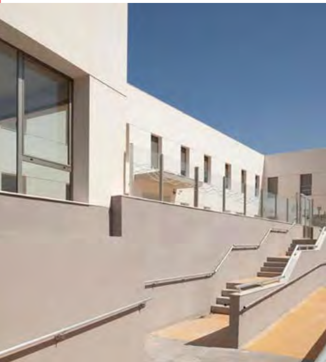
Residencia Garrucha Indasalud Levante (Almería) Sistema instalado: Q-ton Bomba de calor con CO 2
