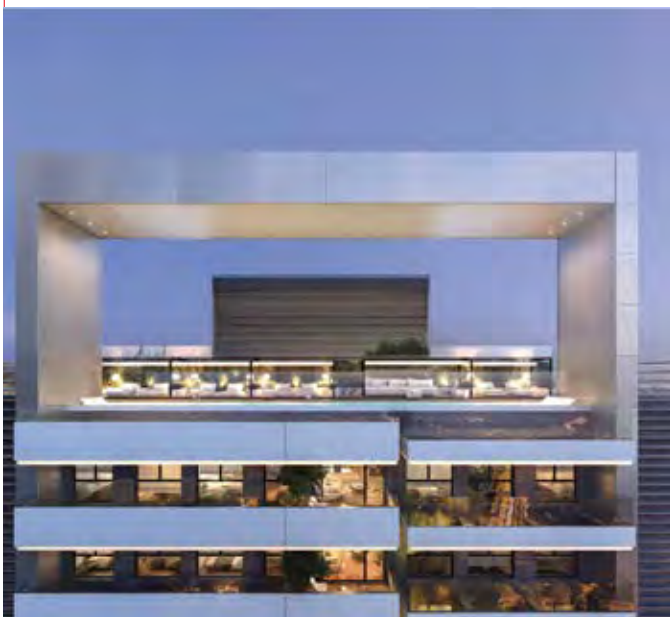
Torre Madrid Skyline (Madrid) Sistema Instalado: Q-ton Bomba de calor con CO 2
