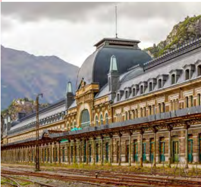
Estación Internacional de Ferrocarriles de Canfranc, Jaca (Huesca) Sistema Instalado: Q-ton Bomba de calor con CO 2
