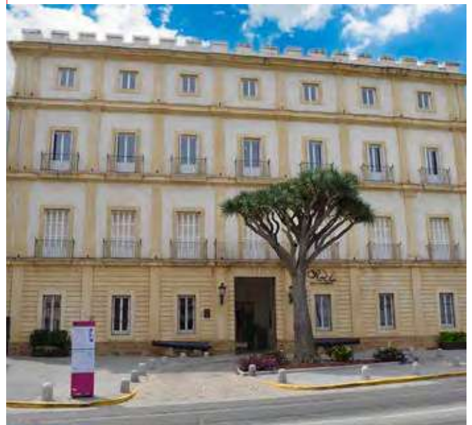
Centro Cultural Reina Sofía (Cádiz) Sistema Instalado: KXZ (VRF)
