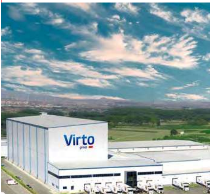
Oficinas Virto Azagra (Navarra) Sistema Instalado: KXZ (VRF) y Recuperadores
