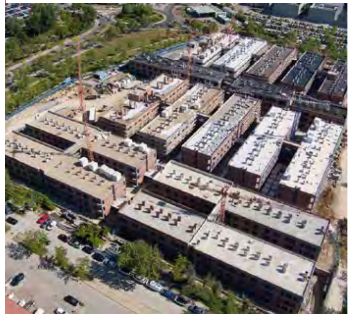
1.134 Viviendas Fractal San Sebastián de los Reyes (Madrid) Sistema Instalado: Q-ton Bomba de calor con CO 2
