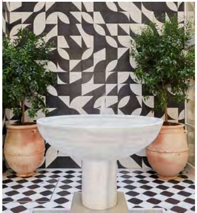
Hotel ICON Malabar en Barrio Soho (Málaga) Sistema Instalado: Q-ton Bomba de calor con CO 2 y KXZ (VRF)
