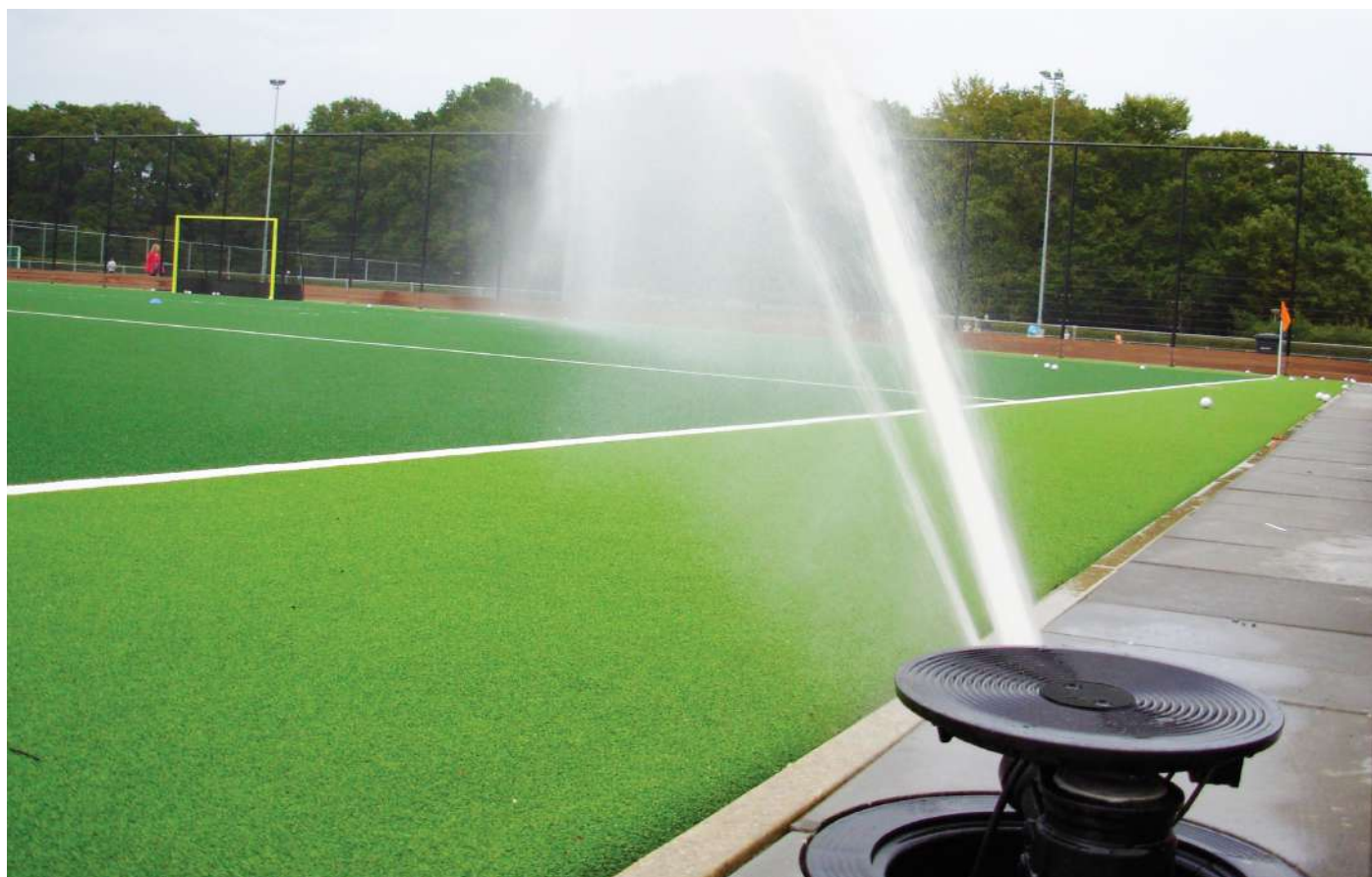
Cañón PERROT VP3 en funcionamiento.
