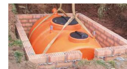
NECOR 5 vivienda unifamiliar
