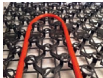
Bloqueo del tubo sin clips con el paso entre tubos múltiple de 50 mm
